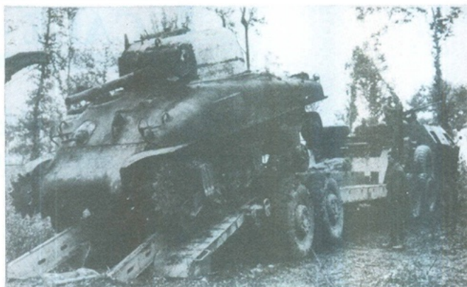
Een uitgebrande Sherman wordt achteruit op de M15 trailer getrokken. Zie hoe de loopwielen van de Sherman tussen de achterwielen van de M15 doorrijden.
